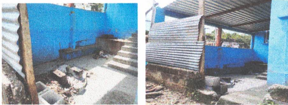
Foto1: REMOZAMIENTO DE COCINA
