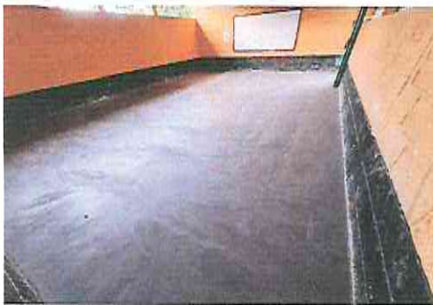
Foto 5: Sustitución de piso de torta de concreto
