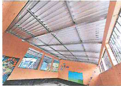
Foto 4: Sustitución de estructura de soporte de madera, por metal
