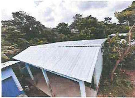
Foto 3: Sustitución de lámina, por lámina troquelada aluzinc calibre 26
