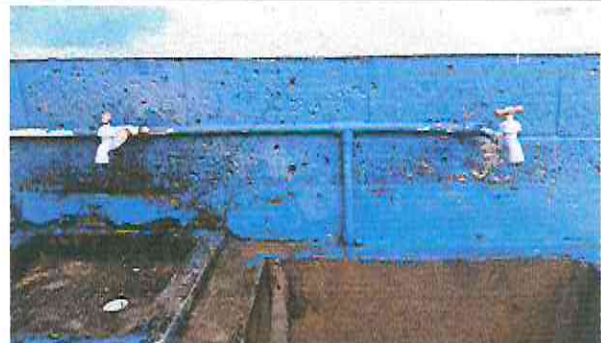
Foto 6: Sustitución de llave de chorro
