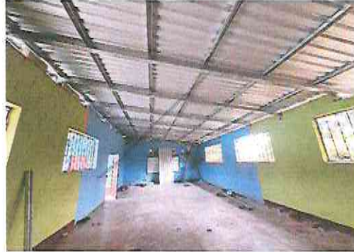
Foto 2: Sustitución de estructura de soporte de madera, por metal
