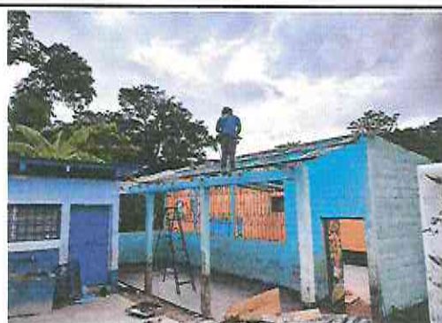
Foto 4: Sustitución de estructura de soporte de madera, por metal
