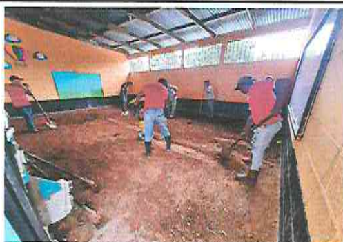
Foto 5: Sustitución de piso de torta de concreto
