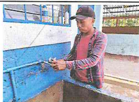
Foto 6: Sustitución de llave de chorro
