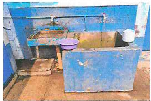
Foto 6: Sustitución de llave de chorro
