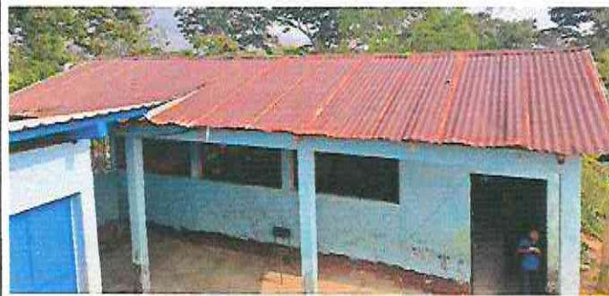
Foto 3: Sustitución de lámina, por lámina troquelada aluzinc calibre 26
