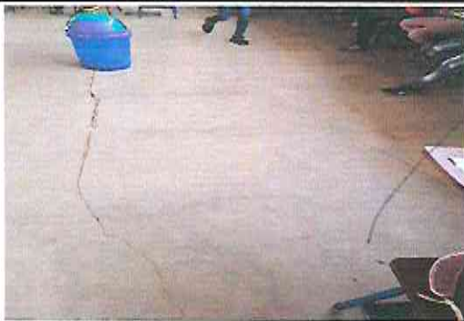
Foto 5: Sustitución de piso de torta de concreto
