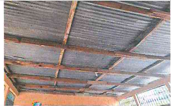
Foto 4: Sustitución de estructura de soporte de madera, por metal
