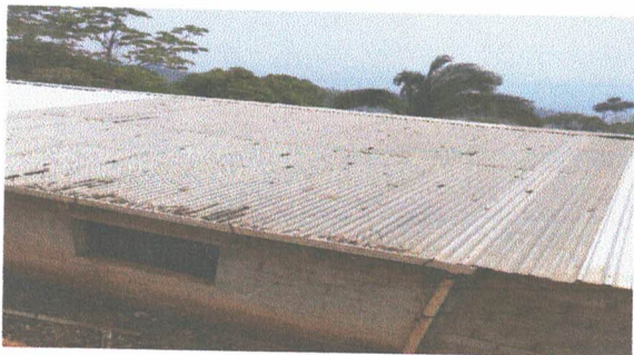
Foto 1: Sustitución de lamina, por lámina troquelada calibre 26.
