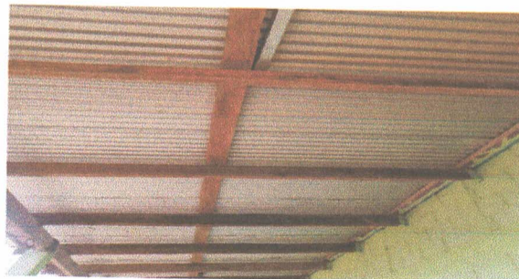
Foto 2: Sustitucion de madera, por estructura metalica.
