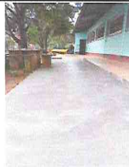
Foto 2: Finalización de banqueta de concreto en el patio.
