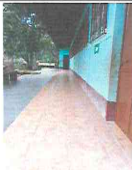
Foto 1: Finalización de intalación de piso ceramico en el corredor
