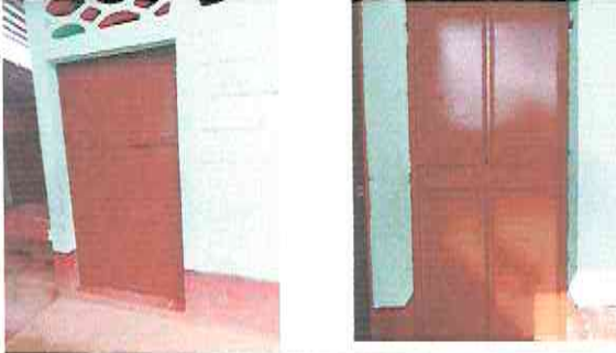
Foto 7. Finalización de mantenimiento de puertas de aulas.
