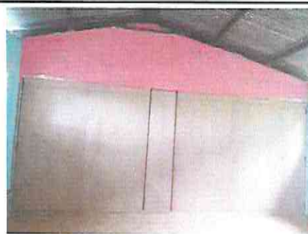
Foto 4: Finalización de división de plywood con estructura metálica.
