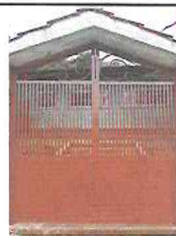
Foto 6: Finalización del mantenimiento y sustitución de chapa del portón de metal.
