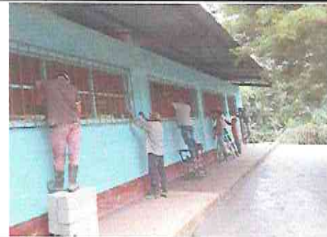
Foto 6: Reparación y lijado de balcones de metal de las aulas.
