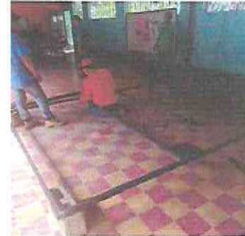
Foto 4: Fabricación de división de plywood con estructura metálica.
