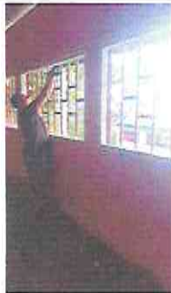
Foto 5: Instalación de ventanas en aulas.
