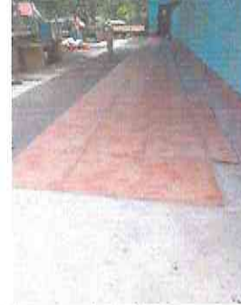
Foto 2: Cambio de piso de concreto a piso ceramico en el corredor.
