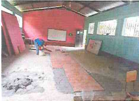
Foto 3: Cambio de piso de concreto a piso ceramico en aula.
