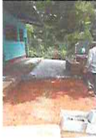
Foto 1: Ampliación de banqueta de patio de concreto.
