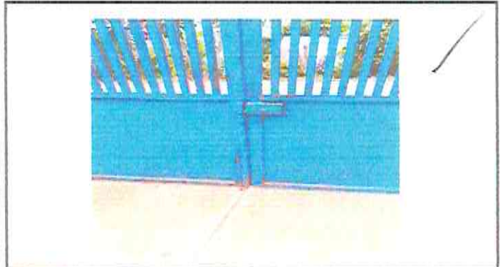
Foto 1 : Se le dara mantenimiento al porton y se le sustituirá la chapa
