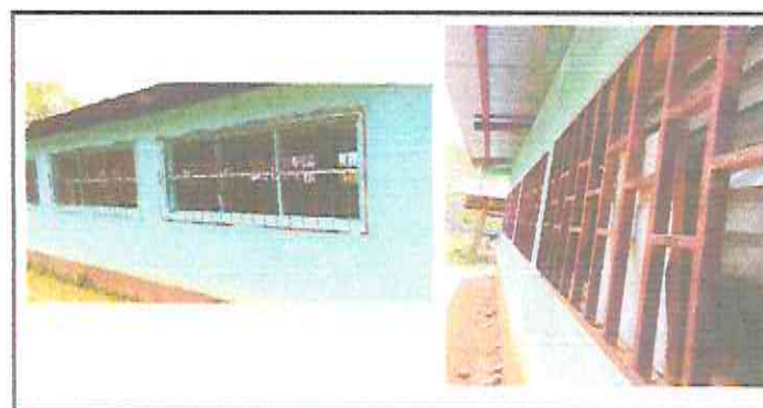
Foto 6 : Reparación y mantenimiento a balcones de metal
