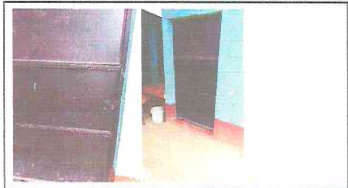
Foto 2: Mantenimiento a las puertas
