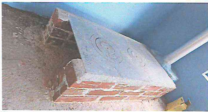
Foto 7: Sustrucción de estufa rural con plancha y chimenea
