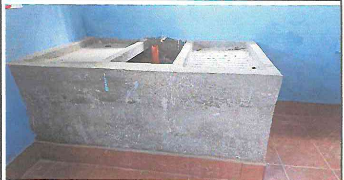
Foto 8: Sustrucción de pila con dos lavaderos
