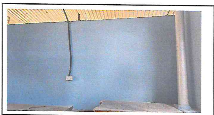
Foto 6: Mejoramiento de electricidad
