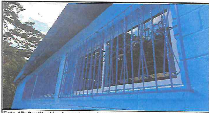
Foto 17: Sustitución de ventanas de madera por ventana PVC 2.40 x 1.00 Mantenimiento con pintura a balcones
