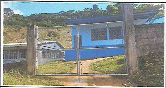
Foto 23: Sustitución de portón entrada principal con tubo galvanizado y malla
