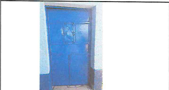
Foto 21: Mantenimiento lijado, cepillado y pintura a puerta
