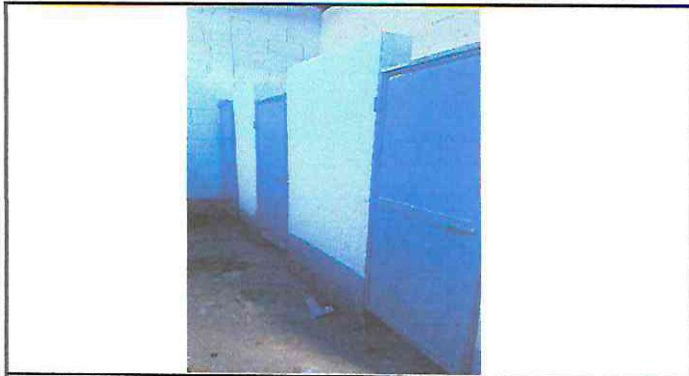
Foto13: Mantenimiento lijado, cepillado y pintura a puertas
