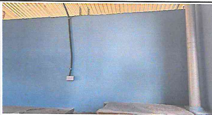
Foto 9: Mejoramiento de paredes con repello y cernido
