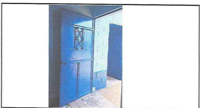
Foto 18: Sustitución de puerta de metal 2.15 x 1.00
