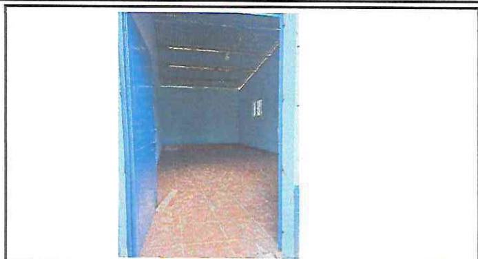
Foto 2: mejoramiento del piso aula 3 por piso cerámico
