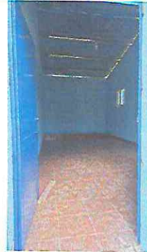
Foto 2: mejoramiento del piso de aula 3 por piso cerámico
