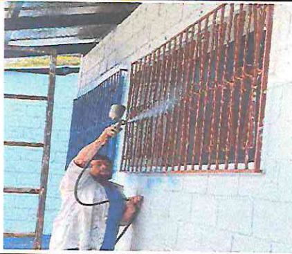
Foto 19: mantenimiento a balcones con pintura
