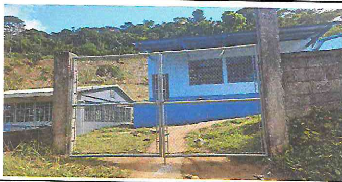
Foto 23: sustitución de porton entrada principal con tubo galvanizado y malla
