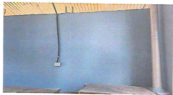
Foto 6: mejoramiento de electricidad
