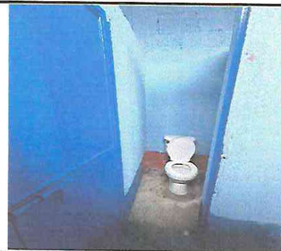
Foto 12: sustitución de sanitario y suministros
