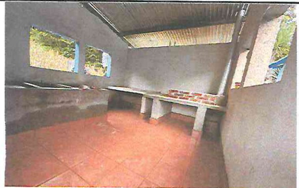
Foto 10: sustitución de piso por piso cerámico
