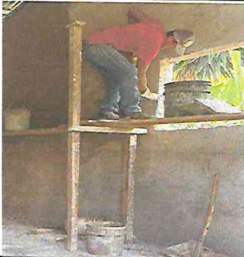
Foto 9: mejaramiento de paredes con repello y cernido
