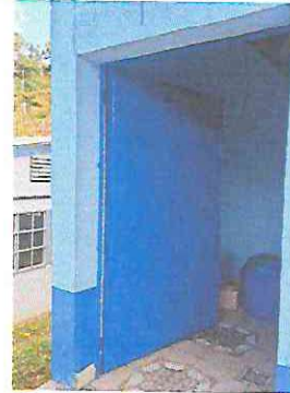
Foto 20: mantenimiento con pintura a puerta
