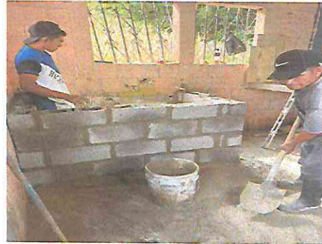
Foto 8: sustitución de pila con dos lavaderos
