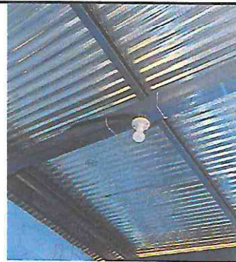
Foto 14: sustitución de electricidad 2 bombillas y 2 apagadores sencillos
