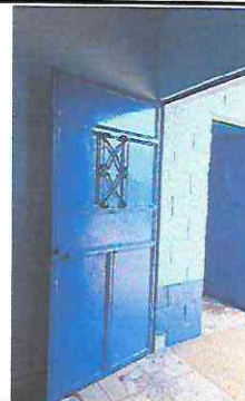
Foto 18: sustitución de puerta de metal 2.15 x 1.00
