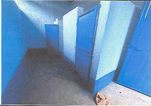
Foto13: mantenimiento lijado, cepillado y pintura a puertas
