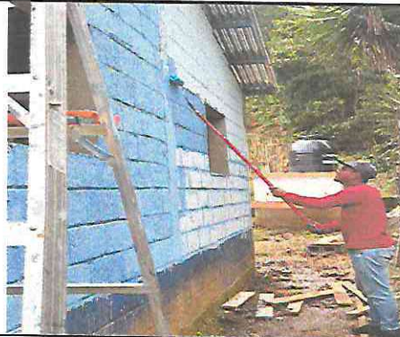
Foto 22: pintura en muros interiores y exteriores (baños, aulas, cocina y dirección)
