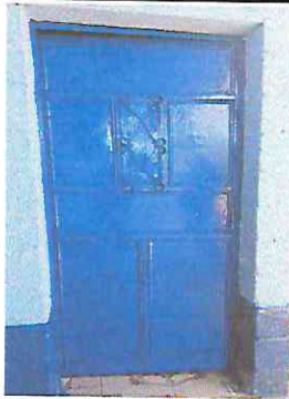
Foto 21: mantenimiento lijado, cepillado y pintura a puerta
