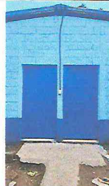
Foto 16: mantenimiento con pintura y cambio de chapa
