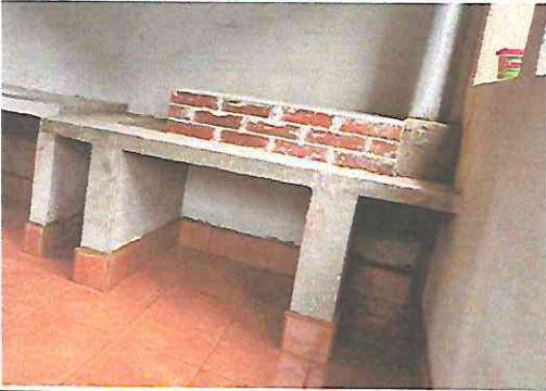
Foto 7: sustitución de pila con dos lavaderos
