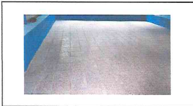
Foto 4: Sustritiución de piso de cemento a piso de granito
