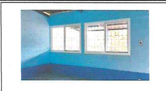
Foto 2: Sustritiución de estructura de metal de ventana a pvc
