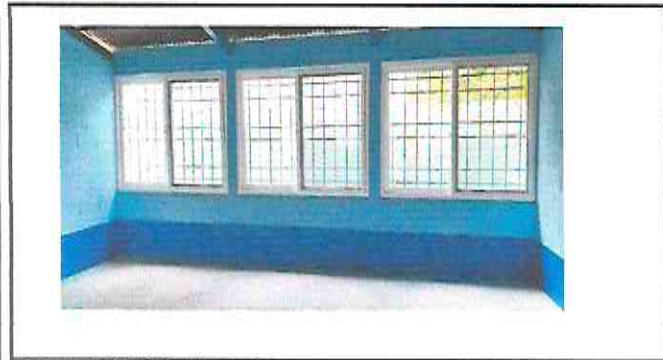
Foto 3: Mantenimiento a balcones de metal
