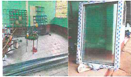
Foto 2: Sustitución de estructura de metal de ventana a pvc
