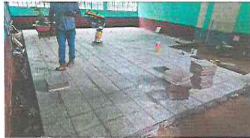
Foto 4: sustitución de piso de cemento a piso de granito
