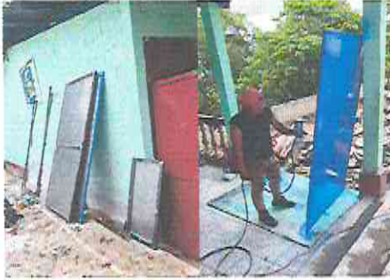
Foto1: Sustitución de puerta Med 1.00 * 2.60 m
