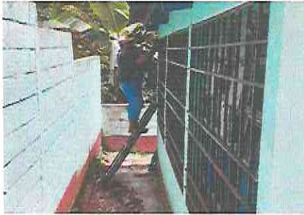
Foto 3: Mantenimiento a balcones de metal
