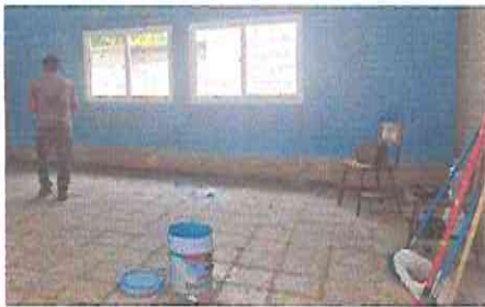
Foto 5: Pintura en muros exteriores e interiores
