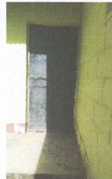
Foto 4: Mantenimiento a puerta lijada, pintado y cambio de chapa.
