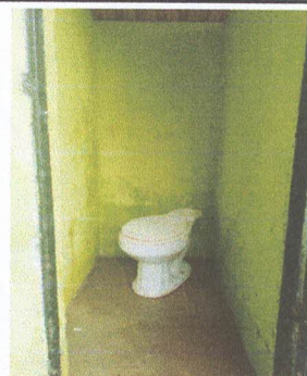
Foto 6: Baños Sustitución de sanitarios y suministros
