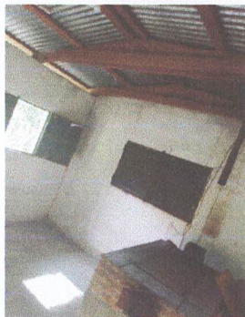
Foto 5: Sustitución de estructura de madera por estructura metálica
