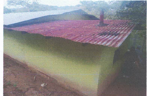
Foto 2: Sustitución de lámina por lámina troquelada scalibre 26
