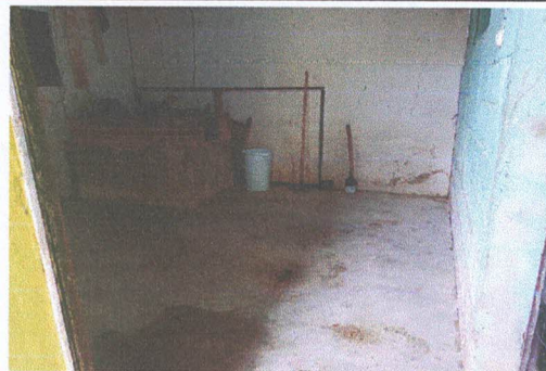
Foto 2: Sustitución de piso por piso cerámico
