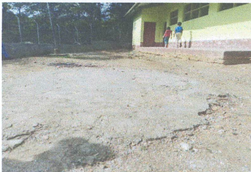
Foto 1: PATIO: Mejoramiento de patio de tierra por loza de concreto
