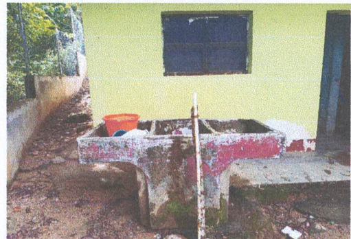
Foto 4: Sustitución de pila movable por pila fija
