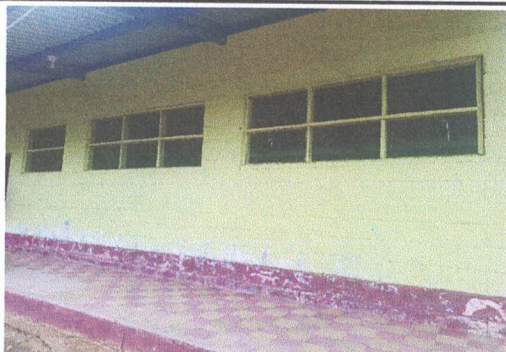
Foto 3: Sustitución de balcones de madera por balcones de metal
