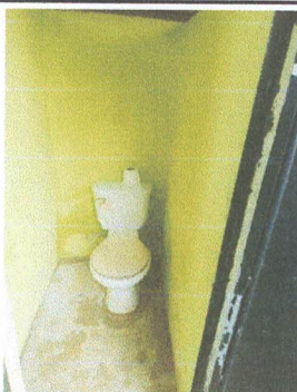
Foto 5: Baños Sustitución de sanitarios y suministros
