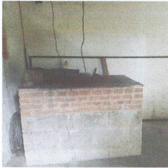
Foto1: Sustitución de polletón, plancha y chimenea
