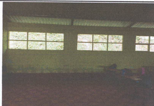
Foto 4: Sustitución de balcones de madera por balcones de metal
