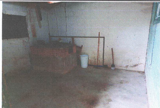
Foto1: Sustitución de piso por piso cerámico
