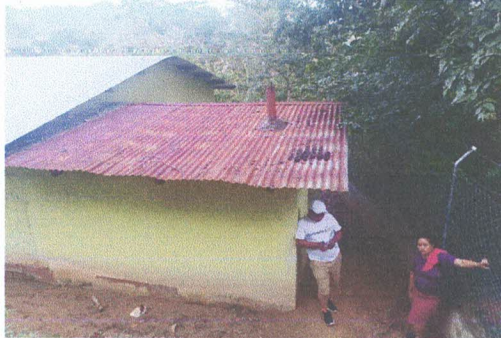
Foto1: Sustitución de lámina por lámina troquelada scalibre 26
