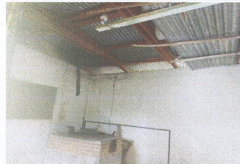
Foto 6: Sustitución de estructura de madera por estructura metálica
