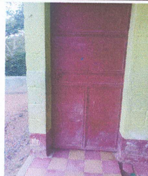
Foto 2: Mantenimiento de puerta lijada y pintada
