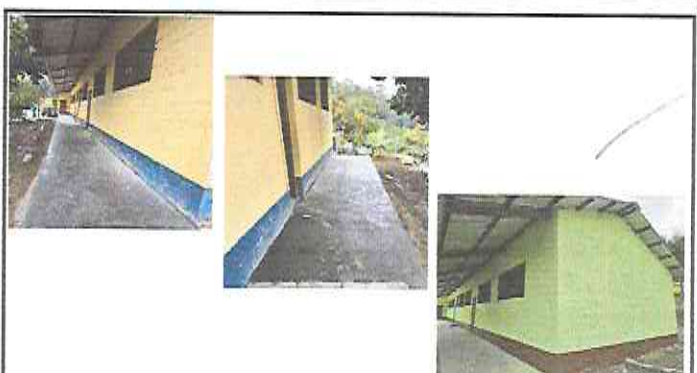
Foto 4: Sustitución de piso de cemento líquido
