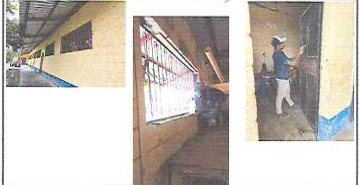
Foto 2. Mantenimiento a estructura de puertas (lijado, aplicación de pintura), Mantenimiento a balcones de metal, Repello en muro (tallado banos [marcos] de ventanas), Sellado de grietas y fisuras en muros
