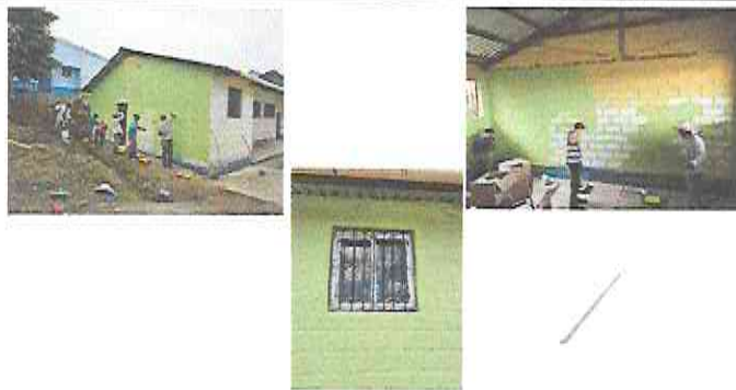
Foto 3. Pintura en muros interiores y exteriores, Sustitución de ventanas de metal por pvc más vidrio
