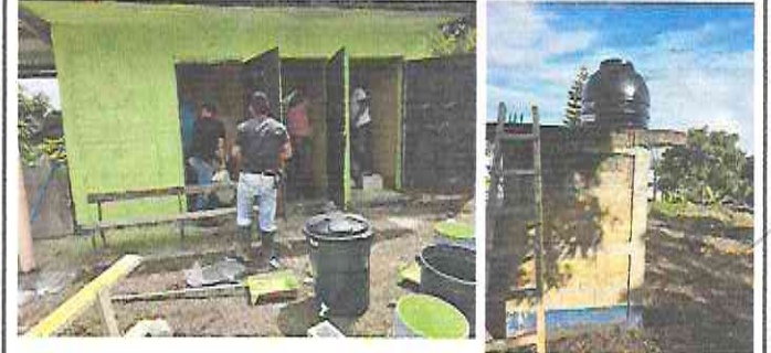
Foto 6: Sustitución de mezcladora lavamanos (contra llave, tubo de abasto), Sustitución de accesorios inodoro (contra llave, tubo de abasto y tanque), Pintura en muros interiores y exteriores, Sustitución de depósito de agua 1100 lt
