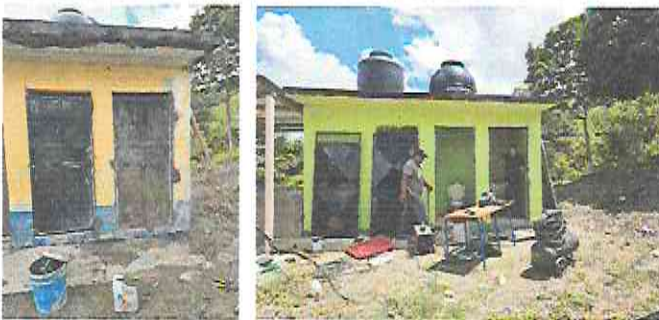
Foto 5: Sustitución de puertas en servicios sanitarios de 2 mts de alto x 0.86 de ancho, Sustitución de plafoneras, Sustitución de interruptores simples (incluye instalación de canaletas), Sustitución de lámparas tipo LED de LISTÓN, Sustitución de cableado eléctrico, Sustitución de tapadera sanitario
