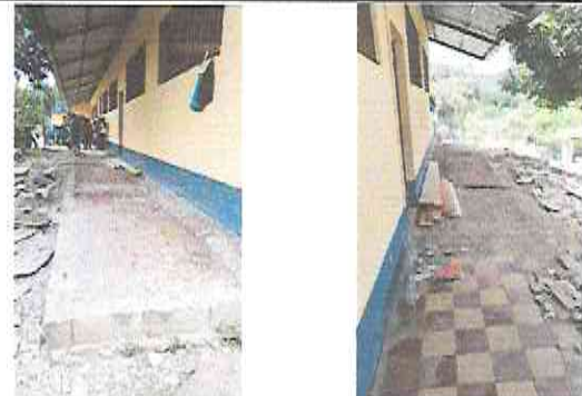
Foto 4: Sustitución de piso de cemento líquido
