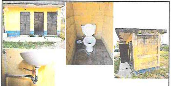
Foto 6: Sustitución de mezcladora lavamanos (contra llave, tubo de abasto), Sustitución de accesorios inodoro (contra llave, tubo de abasto y tanque), Pintura en muros interiores y exteriores, Sustitución de depósito de agua 1100 lt
