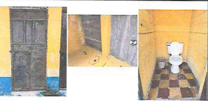
Foto 5: Sustitución de puertas en servicios sanitarios de 2 mts de alto x 0.86 de ancho, Sustitución de plafoneras, Sustitución de interruptores simples (Incluye instalación de canaletas), Sustitución de lámparas tipo LED de LISTÓN, Sustitución de cableado eléctrico, Sustitución de tapadera sanitaria
