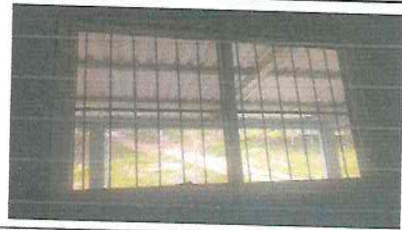
Foto 2: ampliación de ventanas y colocación de balcones y ventanas corredizas
