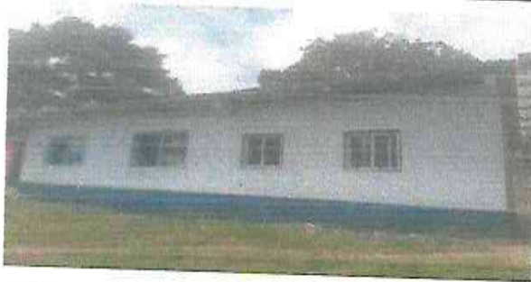
Foto 3: ampliación de ventanas y colocación de balcones y ventanas corredizas
