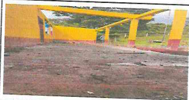
Foto 6: sustitución de torta
