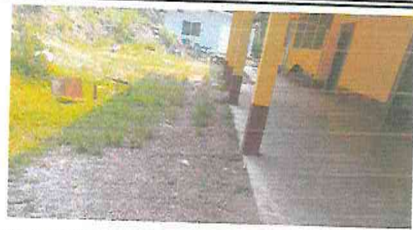
Foto 2: creación de cuneta
