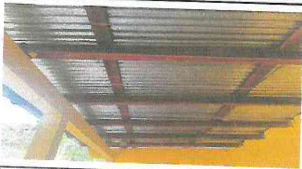
Foto 3: sustitución de madera por costaneras de metal
