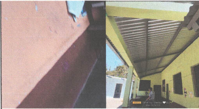
Foto 1: Sustitución de pintura en todo el edificio
