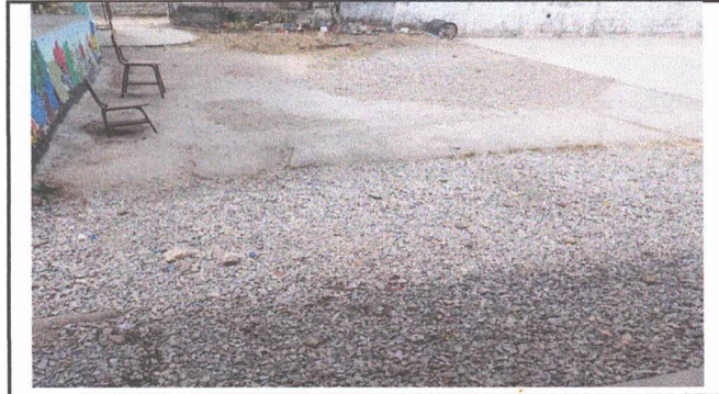
Foto 2: Mejoramiento de torta de concreto
