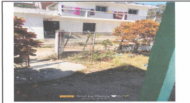
Foto 3: sustitución de porton de metal por metal
