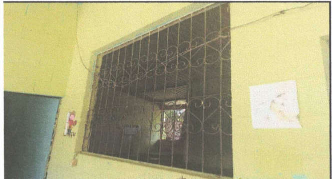
Foto 2: Sustitución de balcon de metal por metal por deterioro
