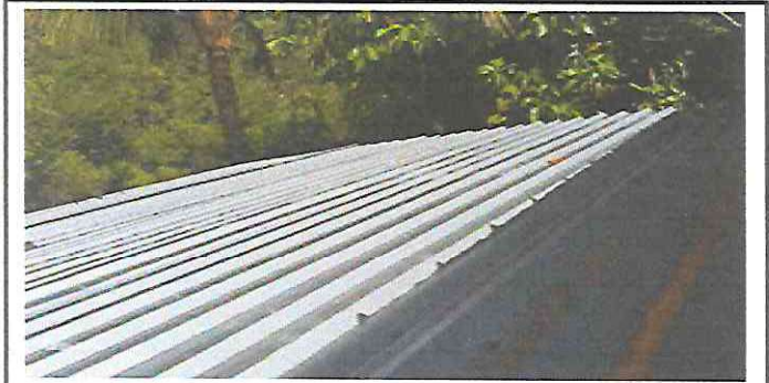
Foto1: SUSTITUCION DE LAMINA POR LAMINA TROQUELADA ALUCIN CALIBRE 26. AREA RECREATIVA.
