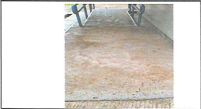
Foto 2: MEJORAMIENTO DE BANQUETA CON CONCRETO. AULA MODULO 3 PREPRIMARIA.
