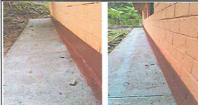
Foto 2: MEJORAMIENTO DE BANQUETA. AULA MODULO 1
