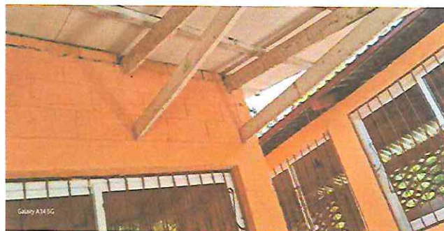
Foto 3: LLENADO DE VACIO ENTRE PARED Y TECHO, CON CONCRETO. AULA MODULO 1.
