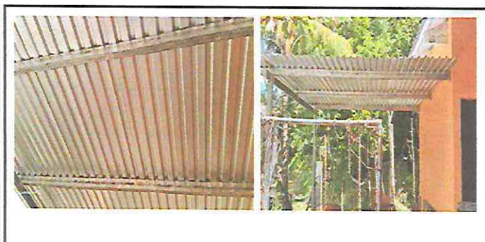
Foto 6: SUSTITUCION DE ESTRUCTURA DE MADERA POR ESTRUCTURA METALICA. AREA RECREATIVA.
