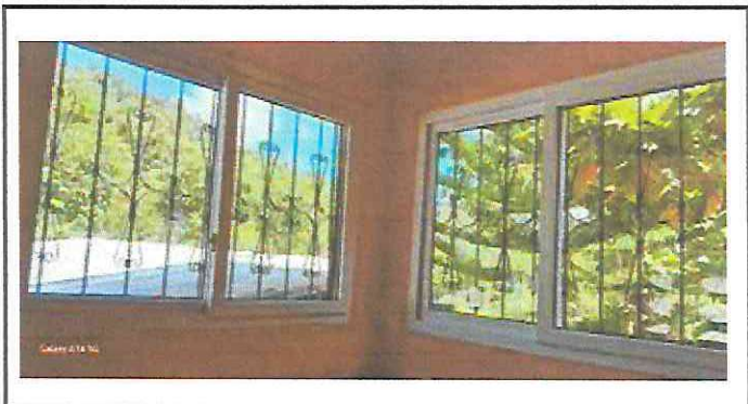
Foto 2: INSTALAR VENTANA DE PVC. COCINA
