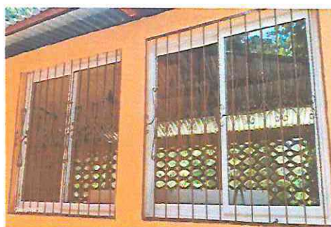
Foto 4: INSTALACION DE VENTANA PVC. AULA MODULO 2
