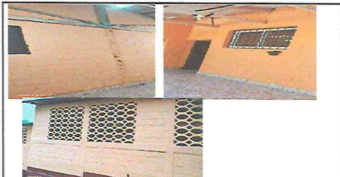
Foto 4: PINTAR PAREDES EXTERIORES E INTERIORES EN AULAS, BAÑOS, DIRECCION Y COCINA.
