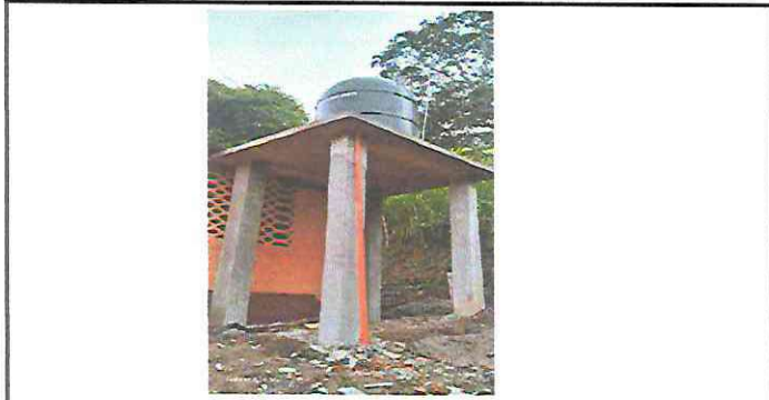
Foto 3: SUSTITUCION DE BASE DE ESTRUCTURA METALICA POR BASE DE CONCRETO PARA LA COLOCACION DE TINACO E INSTALACION DE TINACO EXISTENTE Y ACCESORIOS.
