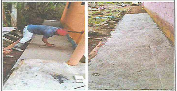
Foto 2: MEJORAMIENTO DE BANQUETA. AULA MODULO 1
