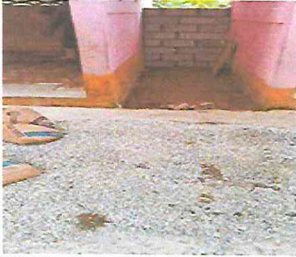
Foto 1: MEJORAMIENTO DE BANQUETA, PASILLO ENTRE AULA 2 Y COCINA.
