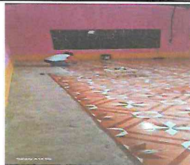
Foto 6: SUSTITUCION DE PISO, POR PISO CERAMICO. AULA MODULO 2
