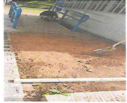
Foto 2: MEJORAMIENTO DE BANQUETA CON CONCRETO. AULA MODULO 3 PREPRIMARIA.
