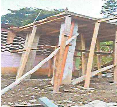
Foto 3: SUSTITUCION DE BASE DE ESTRUCTURA METALICA POR BASE DE CONCRETO PARA LA COLOCACION DE TINACO E INSTALACION DE TINACO EXISTENTE Y ACCESORIOS.
