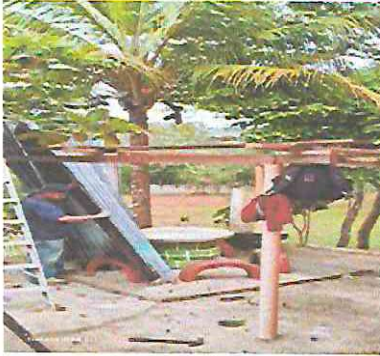
Foto1: SUSTITUCION DE LAMINA POR LAMINA TROQUELADA ALUCIN CALIBRE 26. AREA RECREATIVA.
