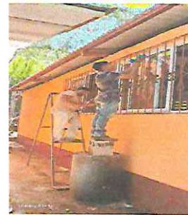
Foto 4: INSTALACION DE VENTANA PVC. AULA MODULO 2
