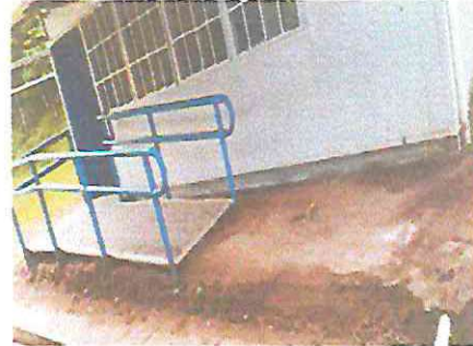
Foto 2: MEJORAMIENTO DE BANQUETA CON CONCRETO. AULA MODULO 3 PREPRIMARIA.
