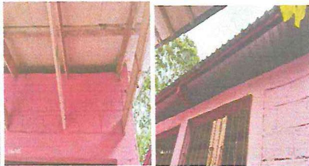
Foto 3: LLENADO DE VACIO ENTRE PARED Y TECHO, CON CONCRETO. AULA MODULO 1 Y 2.
