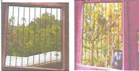
Foto 2: INSTALAR VENTANA DE PVC. COCINA
