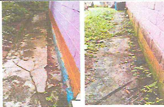
Foto 2: MEJORAMIENTO DE BANQUETA. AULA MODULO 1 ✓
