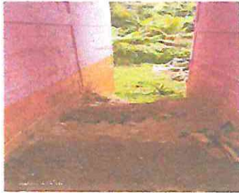
Foto 1: MEJORAMIENTO DE BANQUETA, PASILLO ENTRE AULA 2 Y COCINA.
