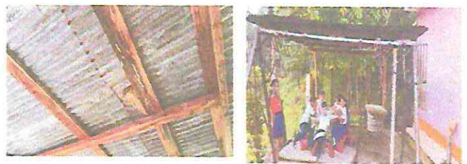
Foto 6: SUSTITUCION DE ESTRUCTURA DE MADERA POR ESTRUCTURA METALICA. AREA RECREATIVA.
