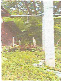
Foto 3: SUSTITUCION DE BASE DE ESTRUCTURA METALICA POR BASE DE CONCRETO PARA LA COLOCACION DE TINACO E INSTALACION DE TINACO EXISTENTE Y ACCESORIOS.
