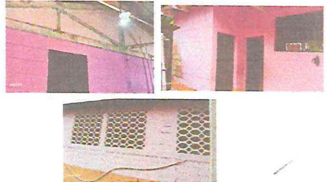
Foto 4: PINTAR PAREDES EXTERIORES E INTERIORES EN AULAS, BAÑOS, DIRECCION Y COCINA.
