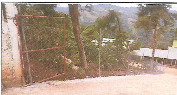
2.3. CAMBIO DE CERCADO DE ALAMBRE Y POSTES DE MADERA, POR MAYA CICLONICA Y TUBERIA METALICA, LADO OPUESTO AL MURO PERIMETRAL.
