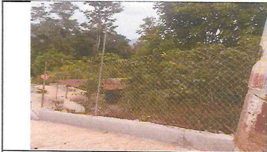
2.2. CAMBIO DE CERCADO DE ALAMBRE Y POSTES DE MADERA, POR MAYA CICLONICA Y TUBERIA METALICA.
