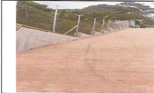
1.2. INSTALACION DE MAYA CICLONICA CON TUBERIA METALICA SOBRE MURO
