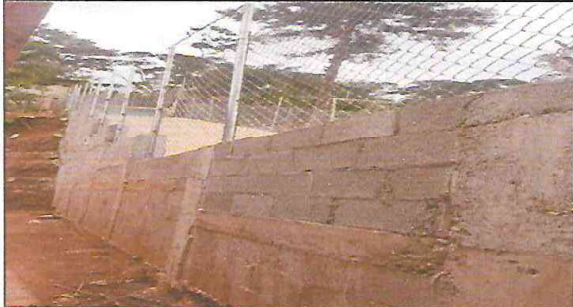
1.1. CONSTRUCCION DE MURO PERIMETRAL PARA PROTECCION DEL ACCESO AL ESTABLECIMIENTO.
