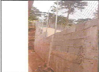
1.1. CONSTRUCCION DE MURO PERIMETRAL PARA PROTECCION DEL ACCESO AL ESTABLECIMIENTO.
