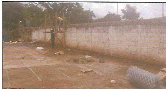
2.1. INSTALACION DE SOLERA TUBERIA METALICA Y MAYA CICLONICA PARA MURO PERIMETRAL PARTE FRONTAL.
