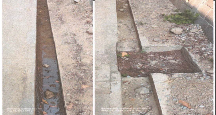
foto 4. instalacion de rejillas de metal sobre cuneta de concreto
