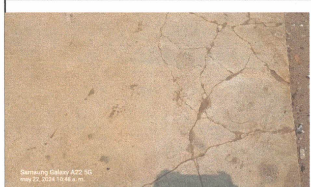
FOTO 2. Reparacion de plancha de concreto
