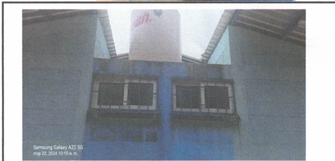
foto 11. instalaion y sustitucion de deposito de agua de 2,500lts
