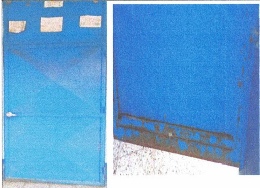
foto 1. mantenimiento a estructura (lijado, cepillado y aplicación de pintura, a 8 puertas.
