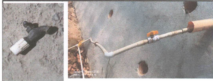
fot 10. sustitucion de llave de globo, susutitucion de llave de cheque,sustitucion de llave de chorro
