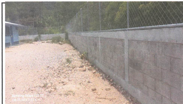
foto5.pintura en muro interiores y exteriores
