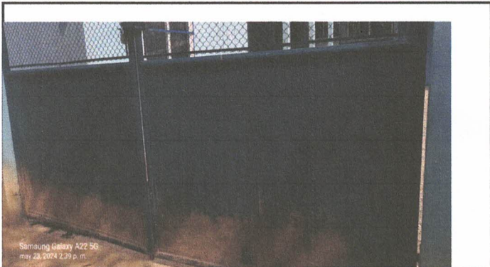
foto7.mantenimiento a porton de metal. de entrada al establecimiento
