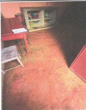
Foto 3: Área de cocina: Cambio de piso cerámico
