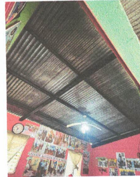
foto 2: Modulo de dirección, colocación de cielo falso.
