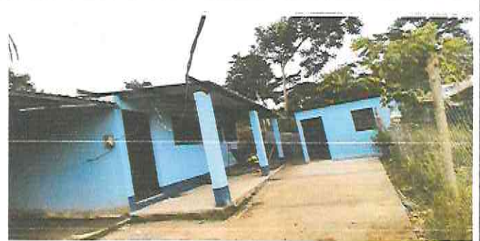
Foto 4: Sustitución de Ventanas tipo percianas por ventanas CPVC corredizas
