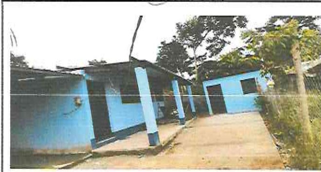
Foto 1: Sustitución de puerta de aula
