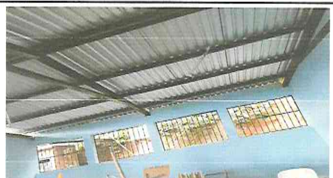
foto 2: Sustitución de lámina por lamina troquelada alucin calibre 26.
