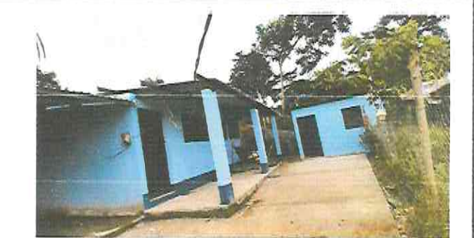
cambio de puerta de la cocina
