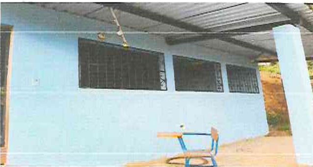
Sustitución de Ventanas
