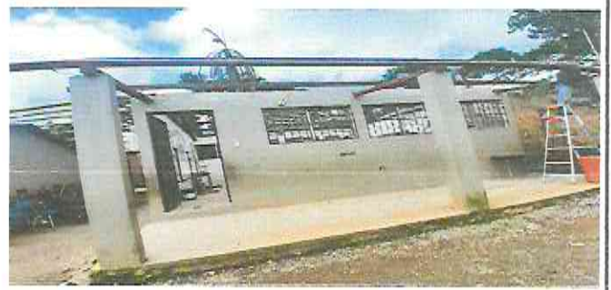
Mantenimiento de estructura metálica
