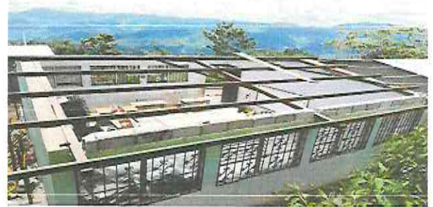
Cambio de lámina por lámina troquelada Alucin calibre 26
