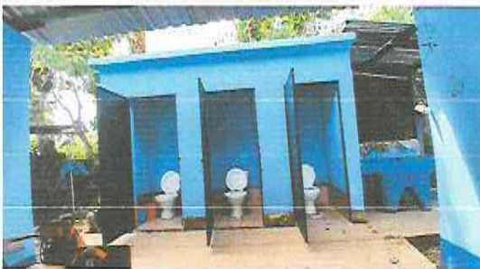
Foto 5: Sustitución puertas, tazas de baño y sus accesorios, tubería para drenaje
