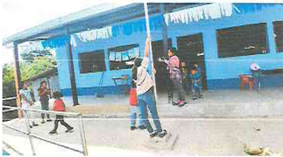
Foto 3: Reparación del sistema eléctrico
