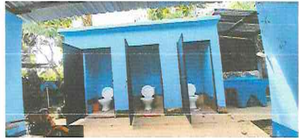
Foto 2. sustitución de torta por piso cerámico en baños
