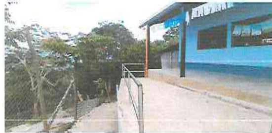
Foto 4: Instalación de canal de metal y bajada de agua pluvial. Instalación de piso cerámico.
