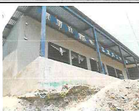
Foto 2: Sustitución de estructura metálica y lámina troquelada alucin calibre 26
