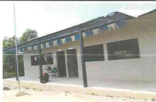
Foto 4: Instalación de canal de metal y bajada de agua pluvial, instalación de piso cerámico.
