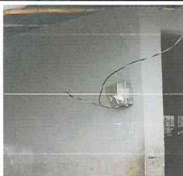
Foto 3: Reparación del sistema eléctrico
