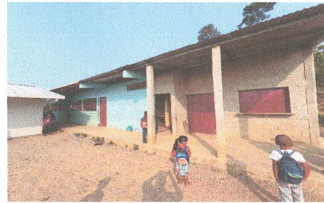
FOTO 4: Pintura en muros exteriores e interiores
