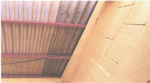
FOTO 1: SUSTITUCION DE LAMINA, POR LAMINA TROQUELADA ALUZINC CALIBRE 26 EN MODULO DE BAÑOS ✓
