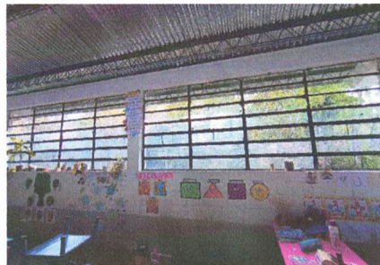
Foto 2. Fabricación e instalación de balcones de hierro en ventanas
