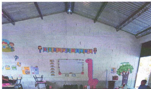
Foto . Reparación de sistema electrico.
