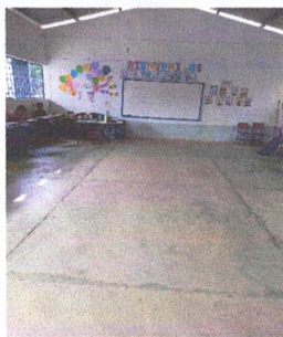
Foto 3. Sustitución de torta de cemento por piso cerámico.
