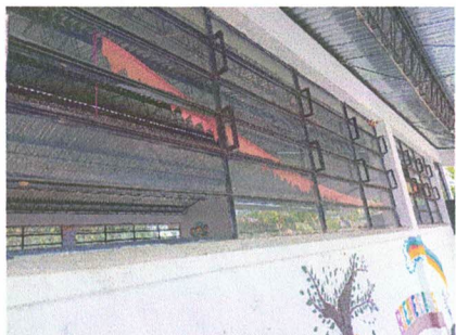
Foto 1. Sstitución de ventans de metal por ventanas PVC
