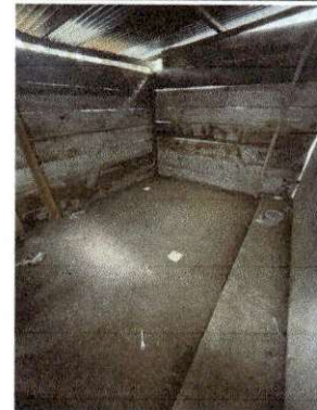
Foto 4: Módulo A, aplicación de pintura
