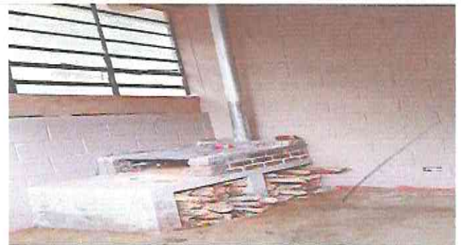
Foto 2: Instalación de estufa rural, incluye chimenea y plancha de metal
