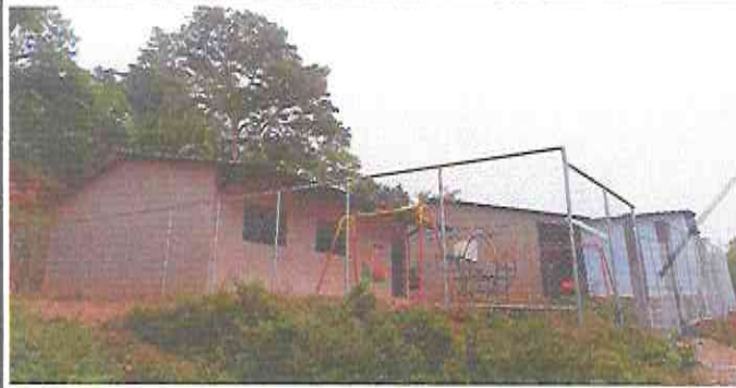
Foto1: Instalación de tubería de HG y malla
