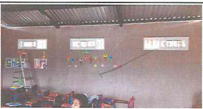
Foto 6: Instalacion de ventanas PVC corredizas
