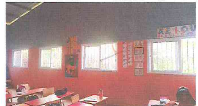
Foto 4: Instalación de ventanas de PVC corredizas 1.00x1.50 mts
