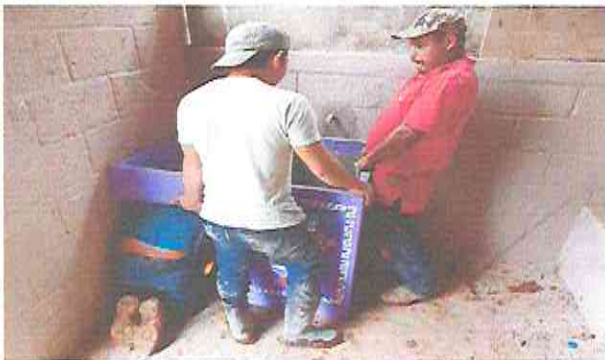
Foto 3: Instalación de pila de concreto prefabricada, incluyendo drenaje y agua 30 mts. lineales.
