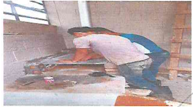
Foto 2: Instalación de estufa rural, incluye chimenea y plancha de metal
