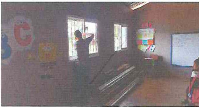
Foto 5: Instalación de ventana PVC 1.00x1.40 mts
