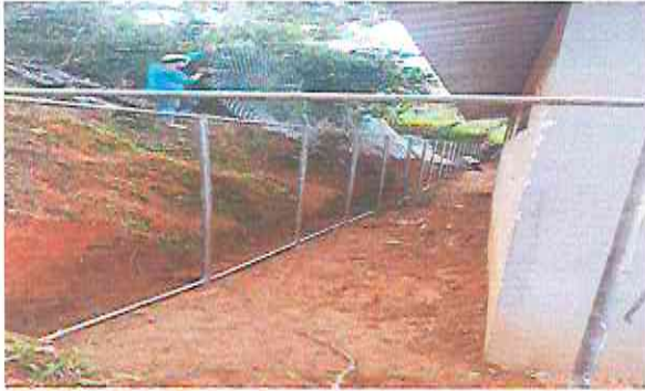
Foto1: Instalación de tubería de HG y malla
