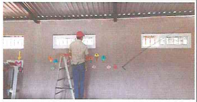
Foto 6: Instalacion de ventanas PVC corredizas
