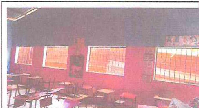
Foto 4: Instalación de ventanas de PVC corredizas 1.00x1.50 mts
