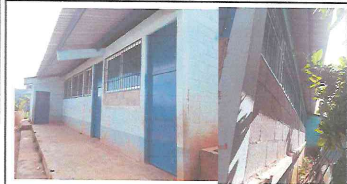
Foto 3: 1.3 Sustitución de balcones por balcones
