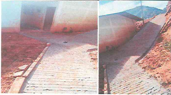
Foto1: 3.1 Reparar y fundir con cemento la rampa de acceso al establecimiento
