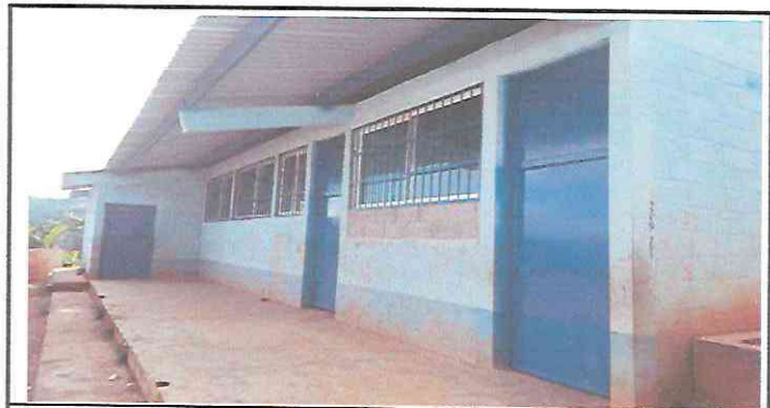
Foto 5: 1.5 Mantenimiento, de puertas.
