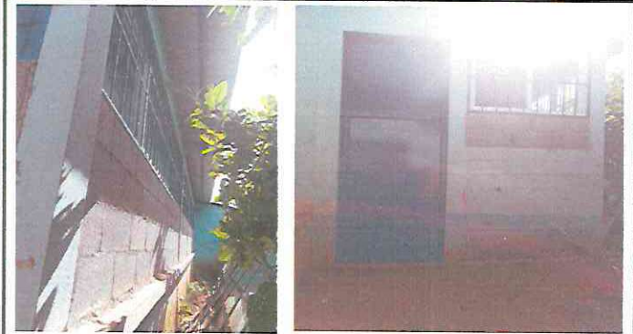
Foto 2: 1.2 Sustitución de ventanas por ventas PVC
