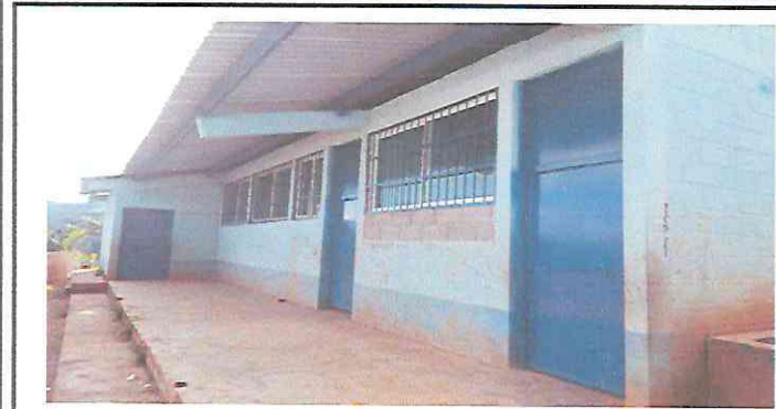
Foto 1: bano de ventanas con block Aula modulo 1
