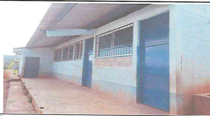
Foto 5: 1.5 Mantenimiento, de puertas.
