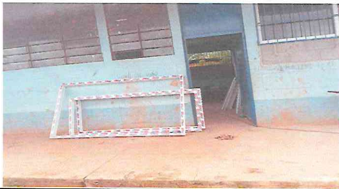
Foto1: bano de ventanas con block Aula modulo 1
