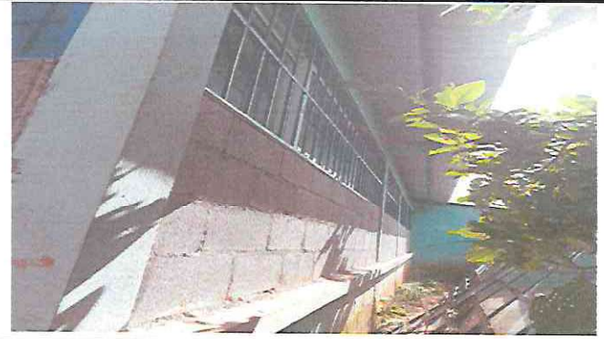
Foto 2: 1.2 Sustitución de ventanas por ventas PVC
