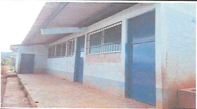
Foto 3: 1.3 Sustitución de balcones por balcones
