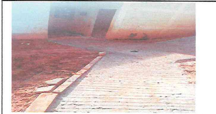
Foto1: 3.1 Reparar y fundir con cemento la rampa de acceso al establecimiento
