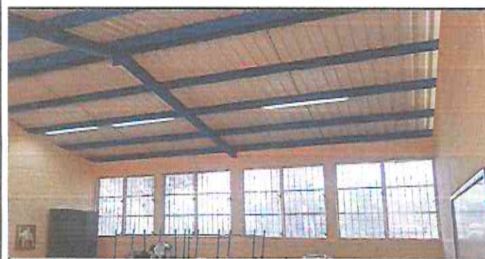
Foto 5: Ejecución de alumbrado eléctrico.
