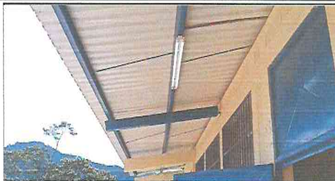
Foto 2: Ejecución de pintado en paredes y muros internos y externos.
