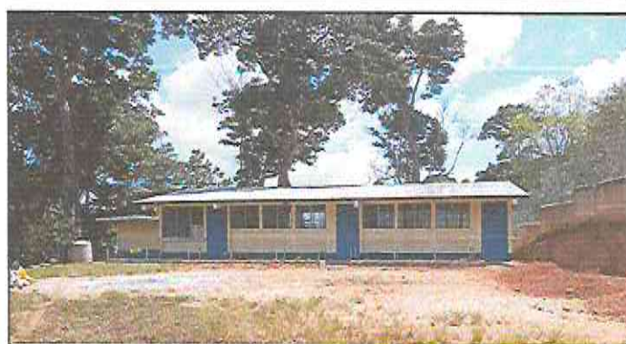
Foto 4: Acabados de mantenimiento de sistema eléctrico.
