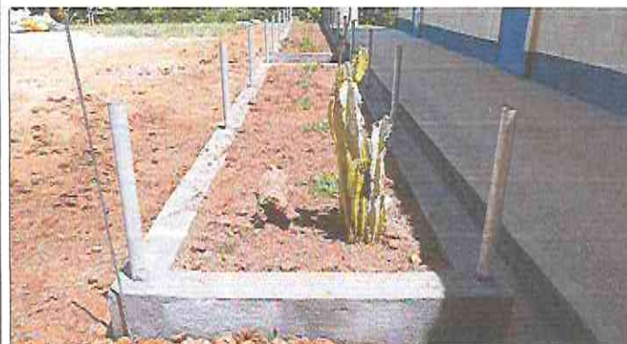
Foto 3: Terminación de caminamiento del establecimiento.
