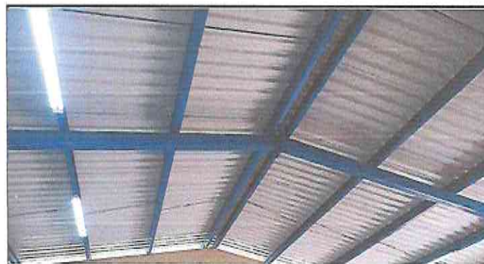
Foto 4: Paso de reparación del sistema eléctrico.
