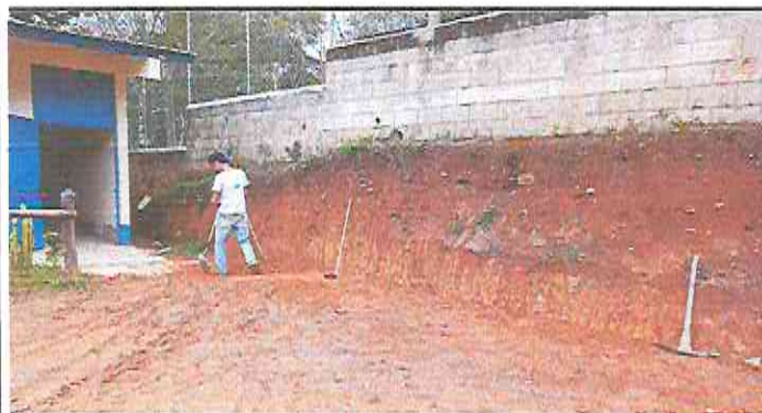
Foto 3: Avance de caminamiento del centro educativo
