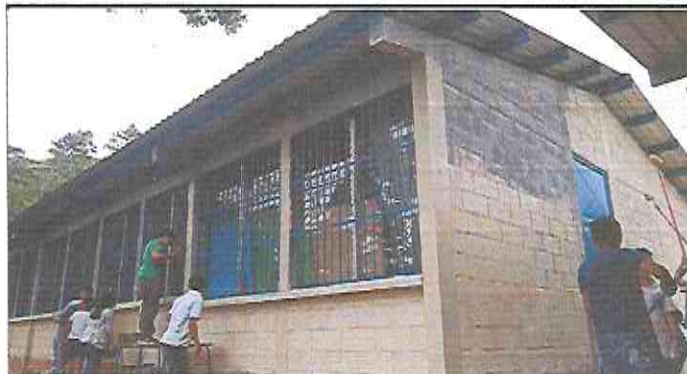
Foto 2: Pintado de partes externas del establecimiento INED TS Aldea La Unión Zacapa.
