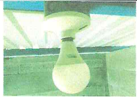
Foto 7: Sustitución de bombillas por lámparas tipo LED
