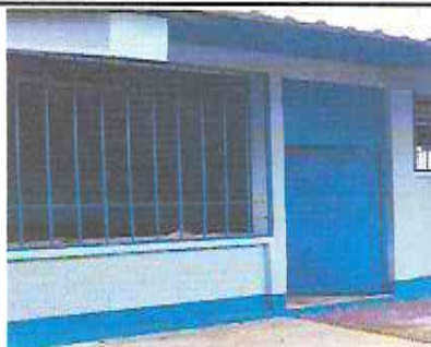
Foto 9: Mantenimiento de puertas de metal (lijado y pintado)
