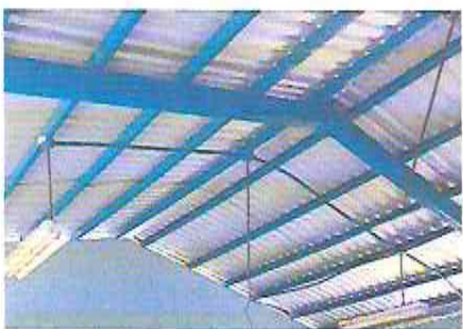
Foto 3: mantenimiento de estructura de soporte de metal.
