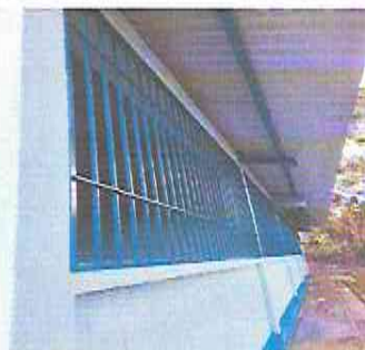
Foto 2: Sustitución de balcones de metal.
