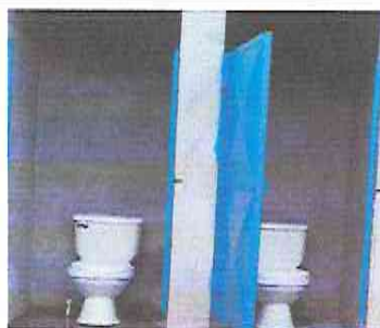
Foto 11: Sustitución de inodoro.
