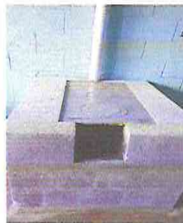
Foto 8: Mantenimiento de estufa rural, (plancha, chimenea, ladrillo tayuyo).
