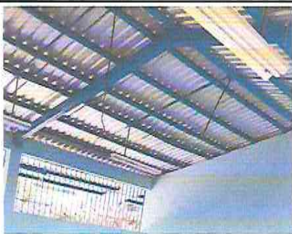
Foto1: Sustitución de lámina, por lámina troquelada calibre 58.
