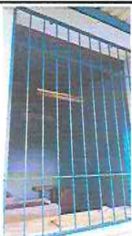
Foto 7: Sustitución de balcones de cocina.
