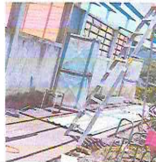
Foto 4: Mantenimiento de puertas (se lijara y pintara).
