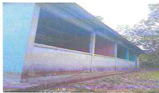
Foto 2: Sustitución balcones por balcones de metal.
