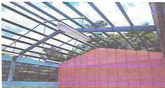
Foto 3: Mantenimiento de estructura de soporte de metal.
