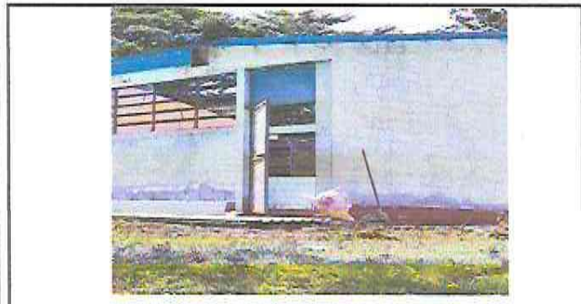
Foto 9: Mantenimiento de puertas de metal (lijado y pintado).
