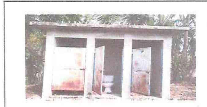
Foto 6: Mantenimiento de puestas de baños (lijado y pintado)
