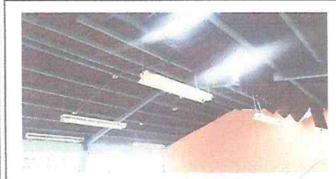
Foto 3: Mantenimiento de estructura de soporte de metal.
