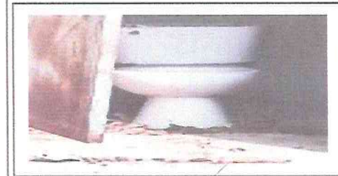
Foto: 11 Sustitucion de inodoros.
