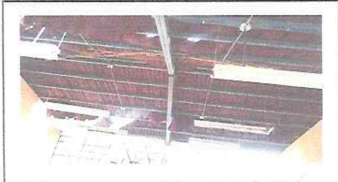
Foto 1: Sustitución de lámina, por lámina troquelada calibre 26.
