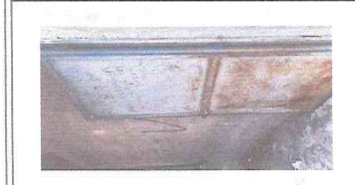
Foto 9: Mantenimiento de puerta de metal (lijado y pintado)
