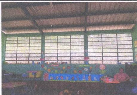
Foto1: Sustitución de ventanas por ventana de PVC
