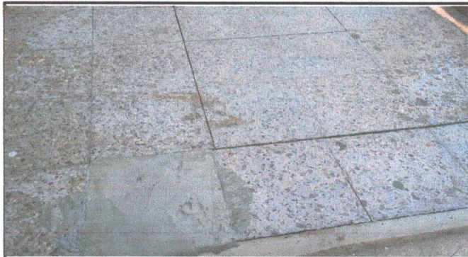
FOTO 5: Sustitución de piso de granito
