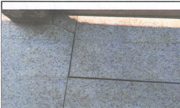
FOTO 6: Sustitución de piso de granito
