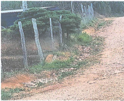
FOTO 3: Reparación de tubo HG y malla galvanizada
