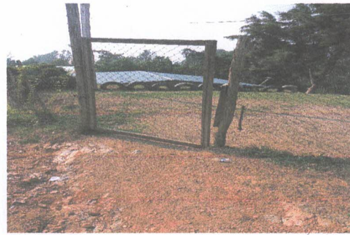
FOTO 4: Reparación de tubo HG y malla galvanizada
