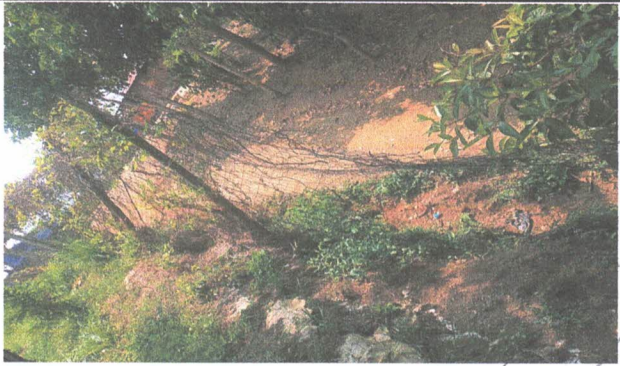
FOTO 1: Reparación de tubo HG y malla galvanizada
