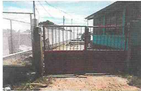
FOTO 2: Sustitución de portón de metal
