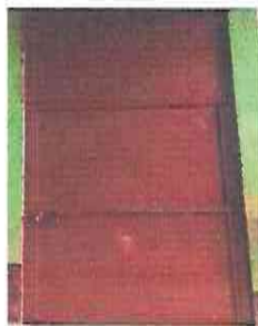
FOTO 3: Mantenimiento a estructura a puertas Y cambio de chapa (lijado, cambio de tubo , cepillado, sujeciones, aplicación de pintura)
