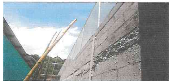
FOTO 6: Reparación de muro perimetral de block TIPO 2 con tubo hg y malla galvanizada, soleras intermedias y columnas
