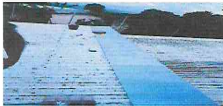
FOTO 1: Sustitución de capote de lámina para lámina troquelada
