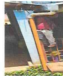
FOTO 4: Sustitución de soporte o pescante de metal para canal Y SUSTITUCION DE CANAL DE PVC
