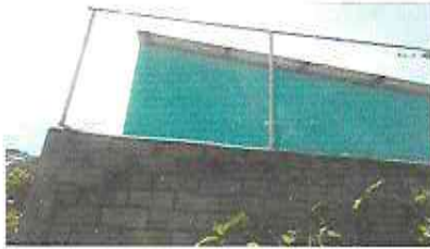
FOTO 7: REPARACION DE MURO PERIMETRAL CON MALLA
