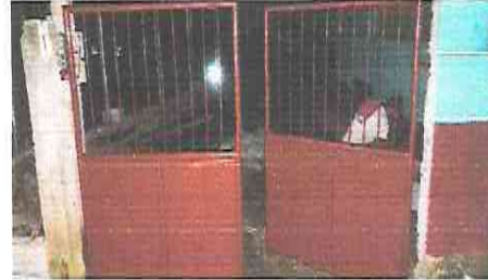
FOTO 2: Sustrucción de portón de metal
