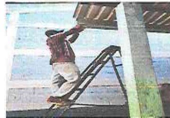
FOTO 4: Sustrucción de soporte o pescante de metal para canal Y SUSTITUCION DE CANAL DE PVC
