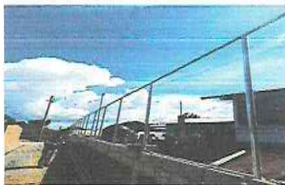
FOTO 7: REPARACION DE MURO PERIMETRAL CON MALLA
