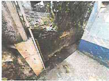
FOTO 9: Reparación de muro perimetral de block TIPO 1
