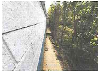
FOTO 6: Reparación de muro perimetral de block TIPO 2 con tubo hg y malla galvanizada, soleras intermedias y columnas
