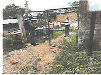
FOTO 2: Sustrucción de portón de metal
