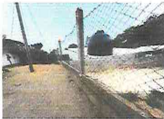
FOTO 7: Reparación de muro perimetral de block TIPO 2 con tubo hg y malla galvanizada, soleras intermedias y columnas
