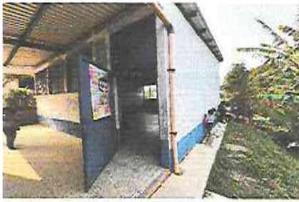
FOTO 3: Mantenimiento a estructura a puertas Y cambio de chapa (lijado, cambio de tubo , cepillado, sujeciones, aplicación de pintura)
