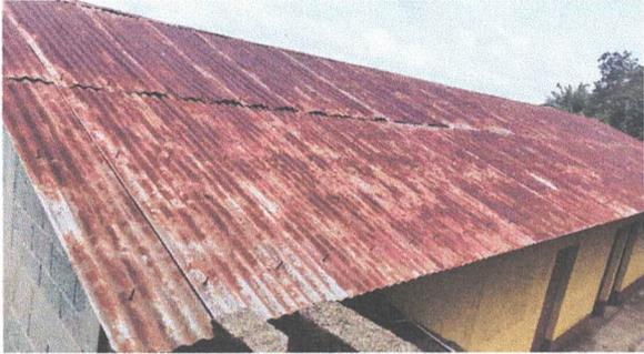
Foto1: Sustitución de lamina por lamina troquelada aluzing calibre 26
